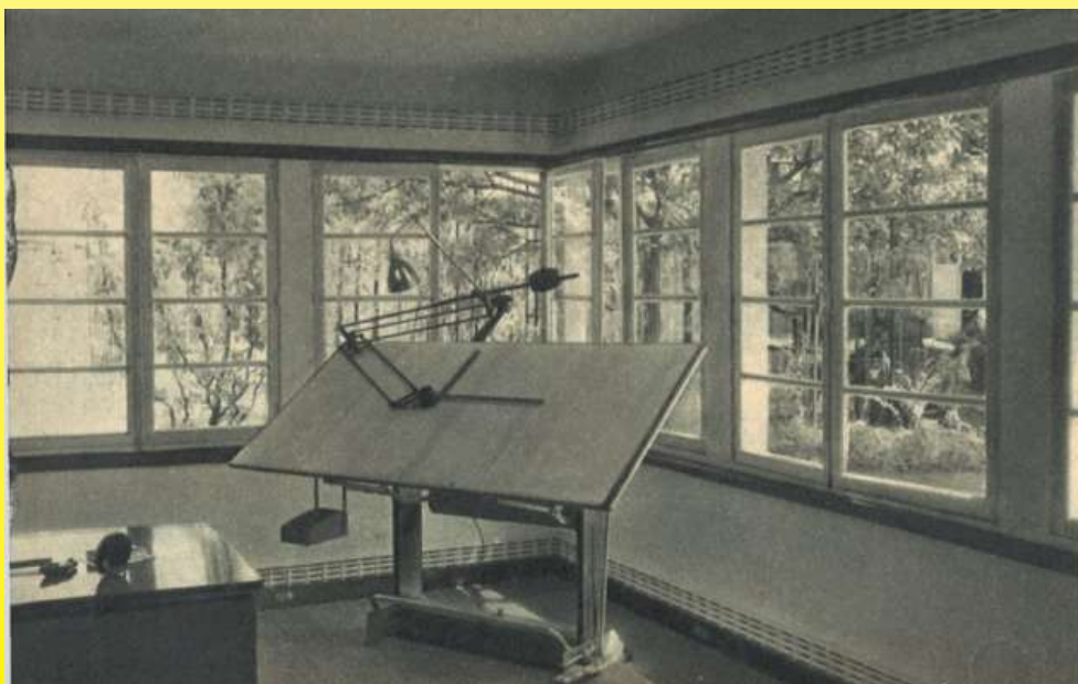
Il nastro riscaldante Rubancalor, prodotto da RAS, avvolge non solo i soffitti, ma anche le basi delle pareti (1958 Ram- bert, Le chauffage, Ultimheat Museum).
